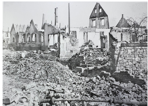
Zerstörungen in Mörsch im April 1945
